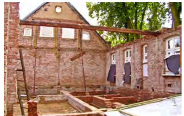
Rückbau des Hofes unter Erhaltung des Charakters der Anlage
